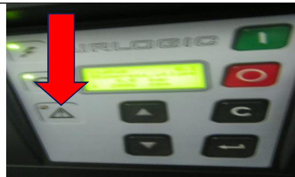
13. Panel kompressor utlopps tryck är 8 bar eller mer ok (larm indikatorlampa)
