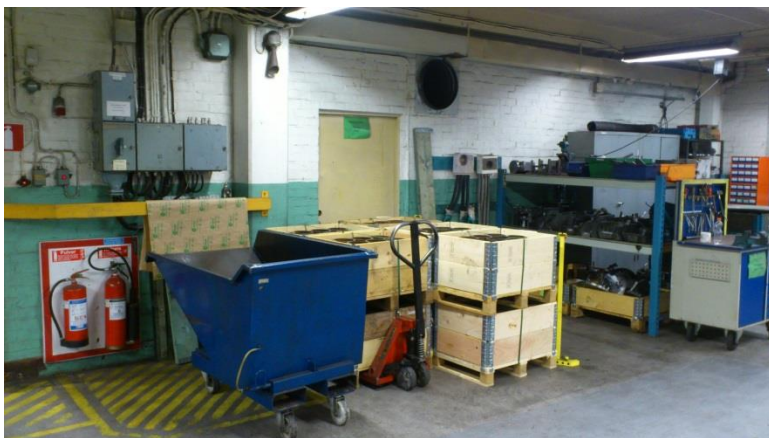
Bild 1 visar att brandsläckaren till vänster i bild numera är fri, och att insatsvarorna har en egen plats samt att pallställaget numera ej är blockerat framifrån.
